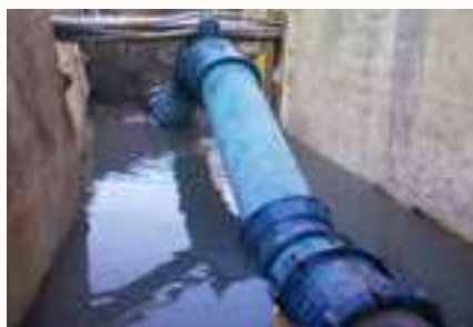
← Remplacement d'une conduite percée
